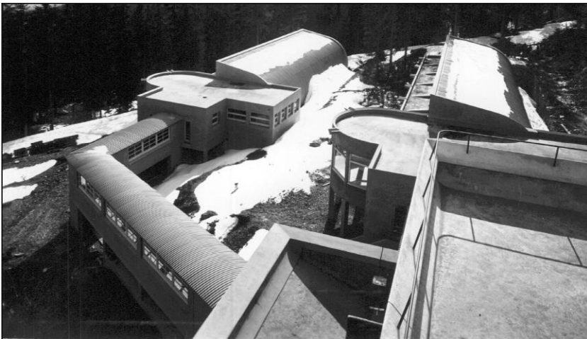
2 . Sanatorium du Roc des Fiz, vue plongeante sur les ailes et les galeries de circulation ; photo Tairraz. Archives CREHA
