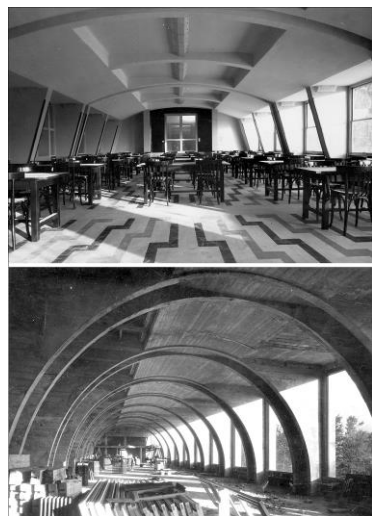
2 . Les volumes des salles à manger de Guébriant (en haut) et de Martel de Janville (en bas). Pol Abraham et H.-J. le Même Archi. Photos G. Tairraz. Archives CREHA
