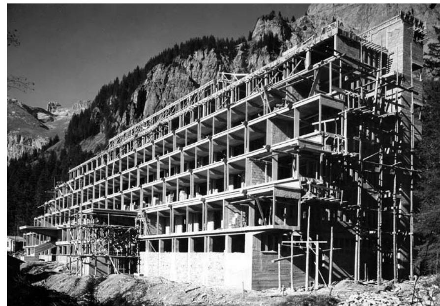
Le chantier de Guébriant
