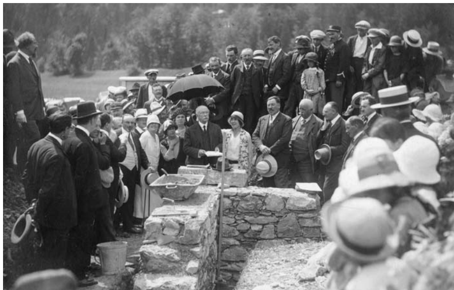
La pose de la première pierre de Praz-Coutant
