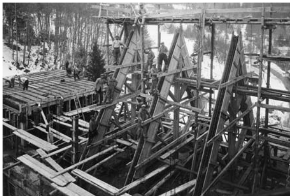
Construction de la chapelle de Martel de Janville
