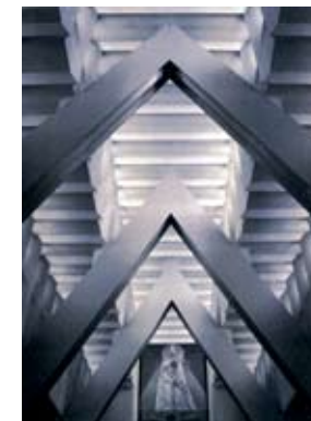
La chapelle de Martel de Janville
